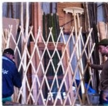
Fabrication du mur
