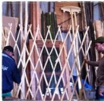
Fabrication du mur
