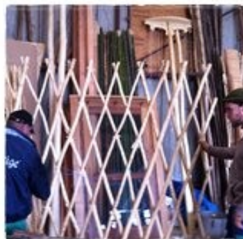
Fabrication du mur
