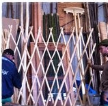
Fabrication du mur
