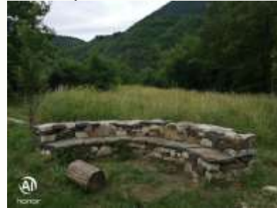
➤ Le mur en pierre sèche
